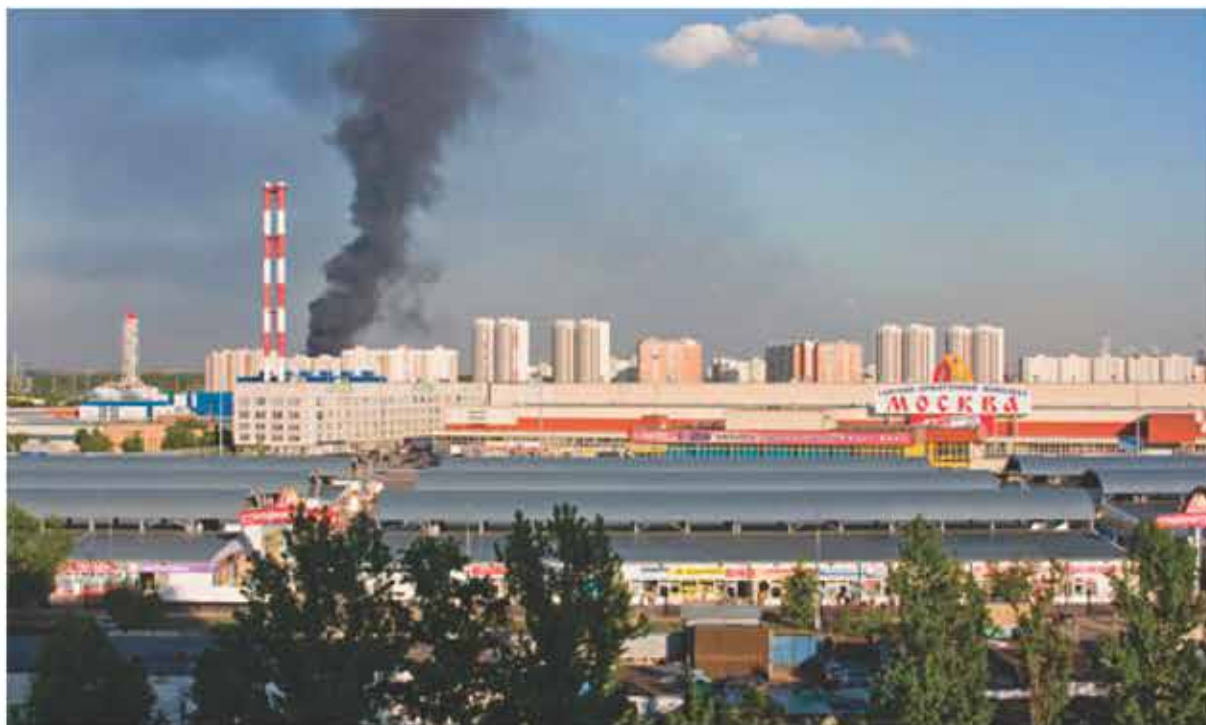
Авария на электростанции «Чагино», 2005 г.
