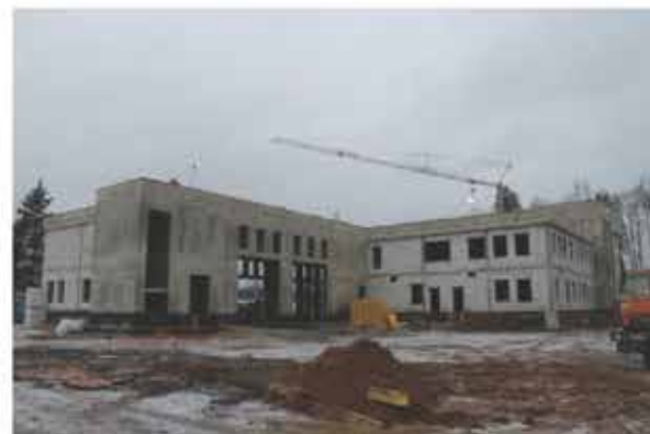
Строительство пожарного депо, Бирилево-Восточное, микрорайон Загорье
